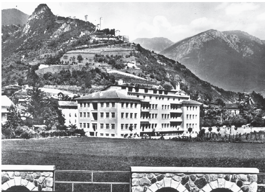
La nuova sede: lato sud.
