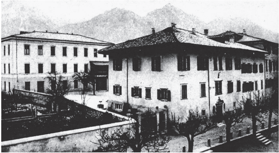
Edifici dell'Asilo-Orfanotrofio dopo la sistemazione 1931 - 1932
