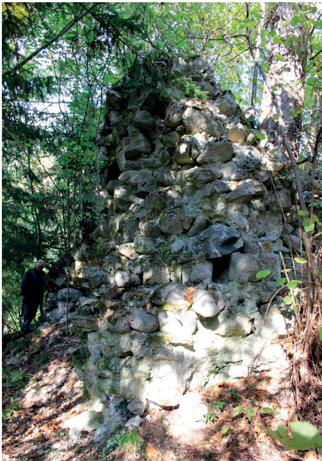
La sommità del mastio.
