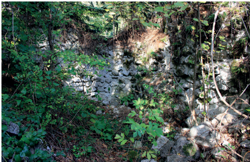
L'interno del presunto mastio. Notare come la rigogliosa vegetazione cresciuta sulle rovine le stia praticamente sbrindellando.
