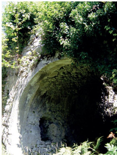
Il passo carraio (N22) con la cisterna.
