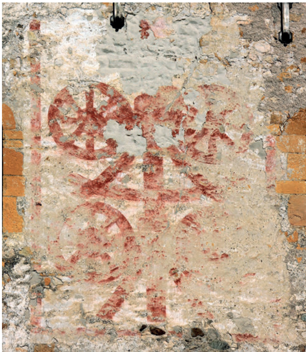
Lo stemma dei da Carrara dipinto a fresco sulla facciata sud-ovest del Mastio di Castel Ivano. Uno stemma analogo doveva essere dipinto sulla facciata meridionale del Mastio di Castellalto, dati gli intensi rapporti che c'erano tra la famiglia dei Castellalto e quella padovana dei da Carrara.
