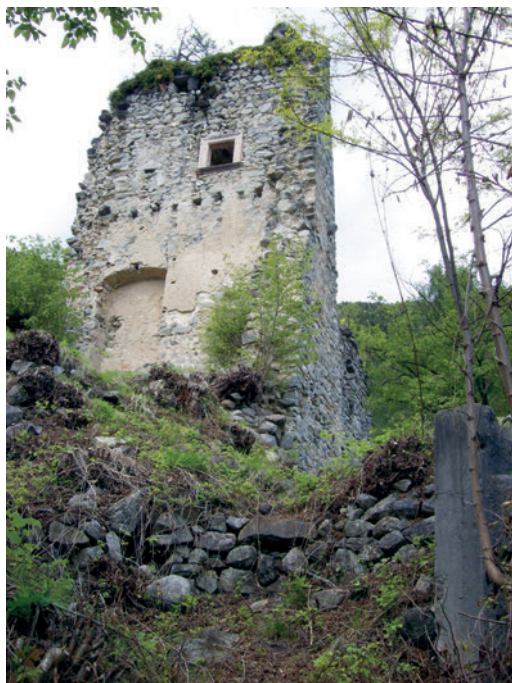
Vista della torre e del piedritto di un portale.
