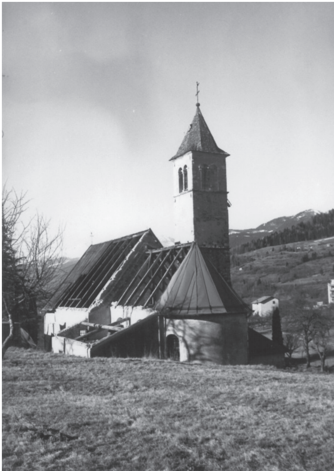
In questa pagina e nelle successive: I danni causati dal vento del 4 gennaio 1976.
