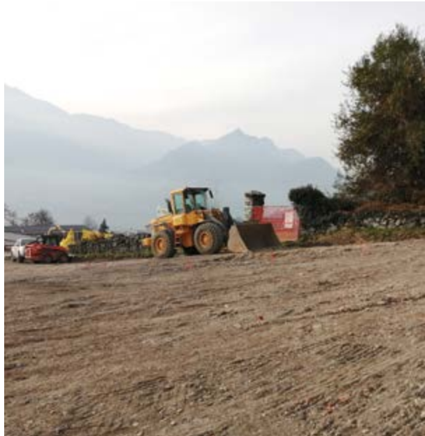
Messa in sicurezza incrocio via S. Giustina
