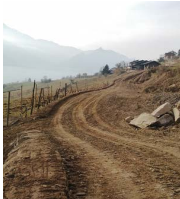
Strada comunale loc. Dami
