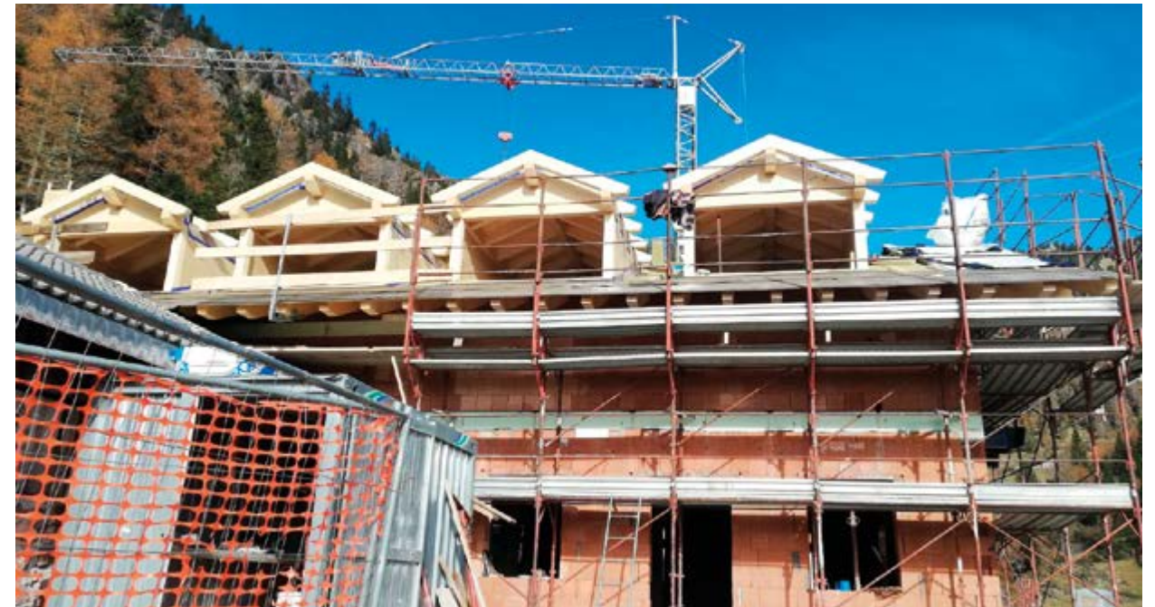
Ristrutturazione ed ampliamento Malga Valsolero di Sopra
