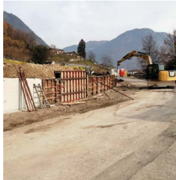
Marciapiede zona cimitero
