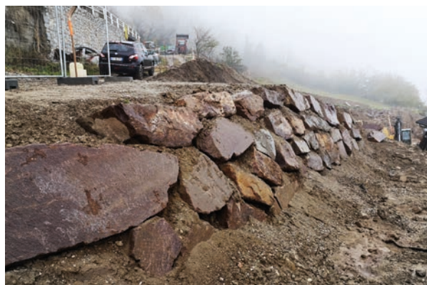
Strada comunale loc. Dami
