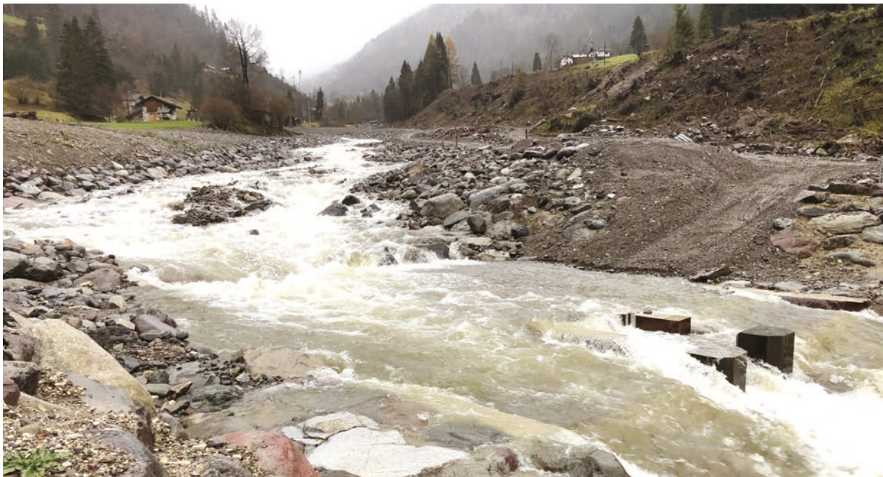
Veduta a nord dell'opera di presa di Calamento
