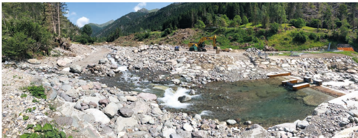
Lavori a nord dell'opera di presa
