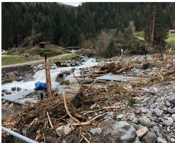
Zona vasche dell'opera di presa il 31 ottobre
