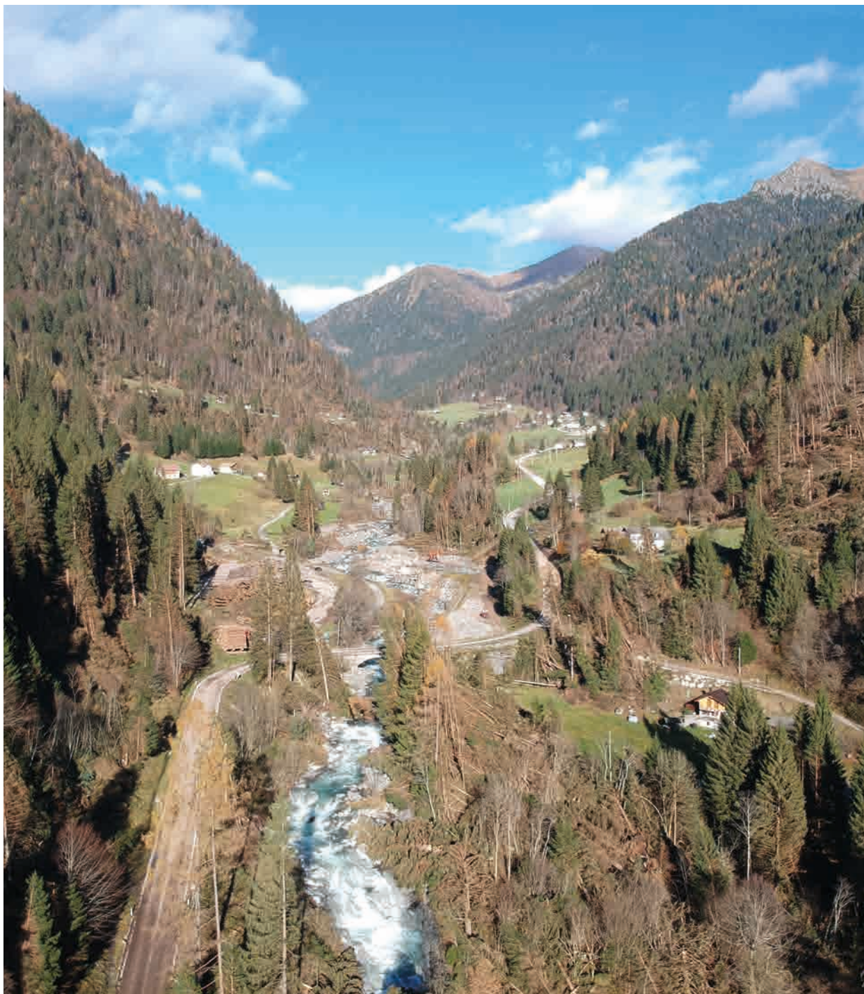
Vista aerea della zona del ponte del Santon
