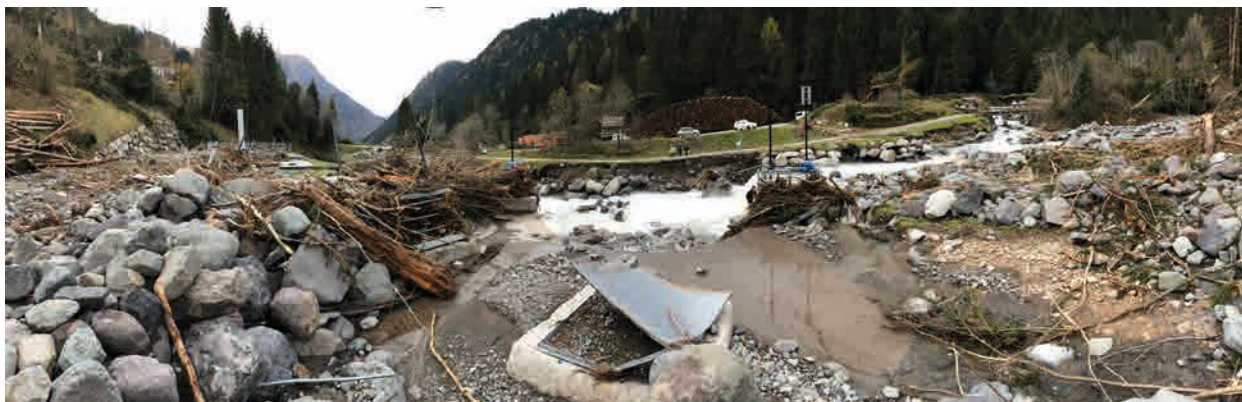
La zona dell'opera di presa il 31 ottobre
