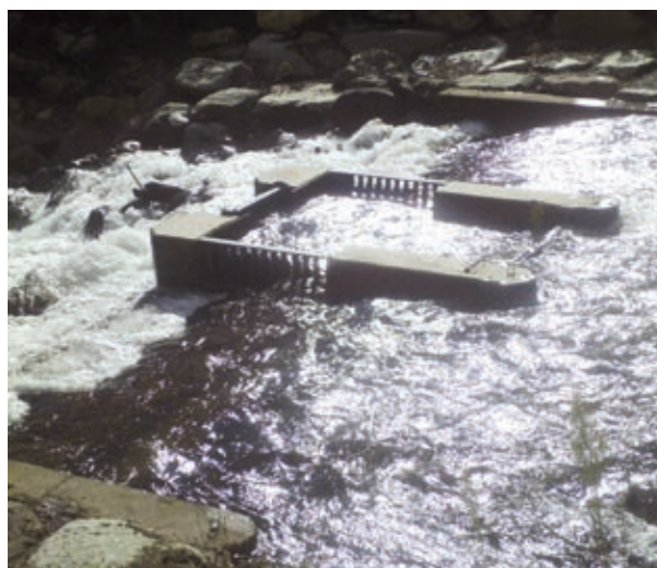
Opera di Presa sul Mado di Calamento in condizioni di piena
