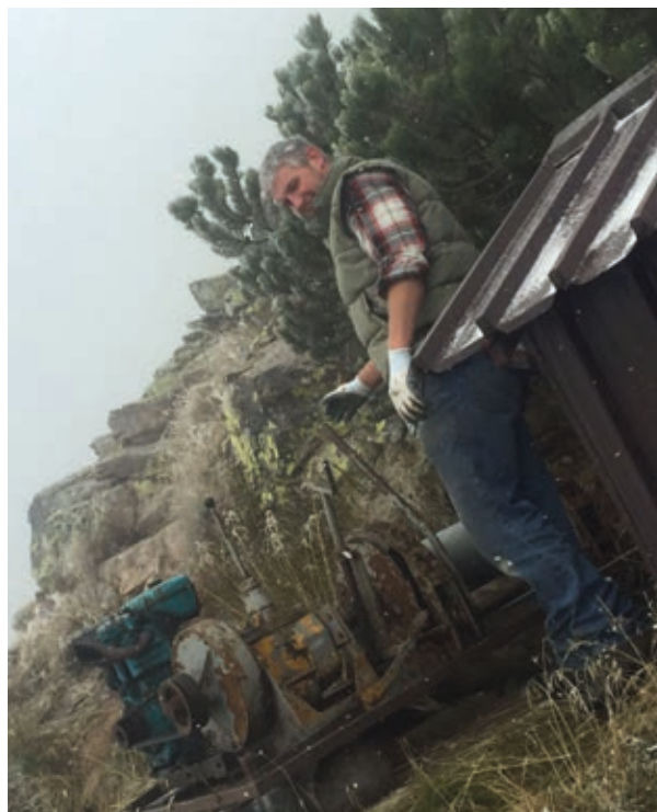
I lavori alla teleferica
