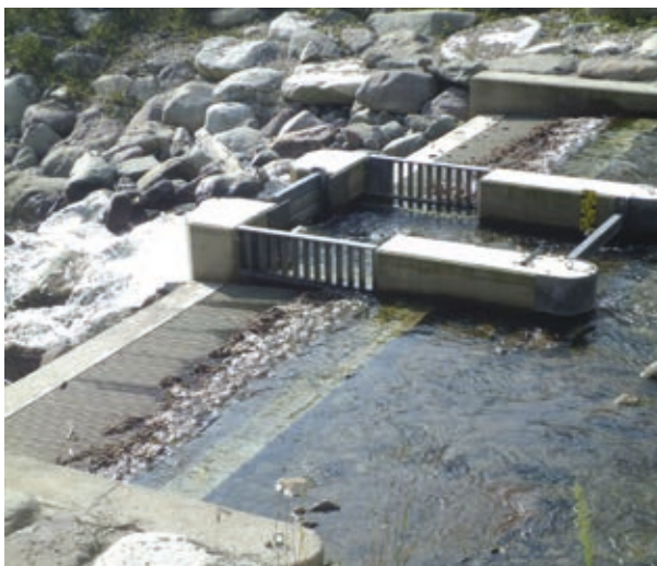
Opera di Presa sul Mado di Calamento in condizioni di magra
