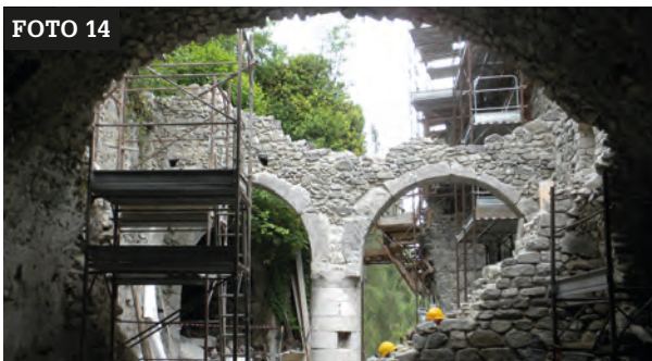
Foto 14: vedute delle volte verso le stalle durante i lavori
