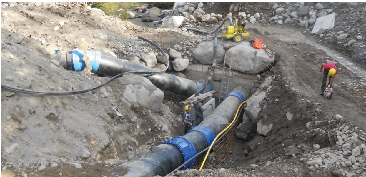
Zona Centrale - attraversamento doppio su torrente Maso
