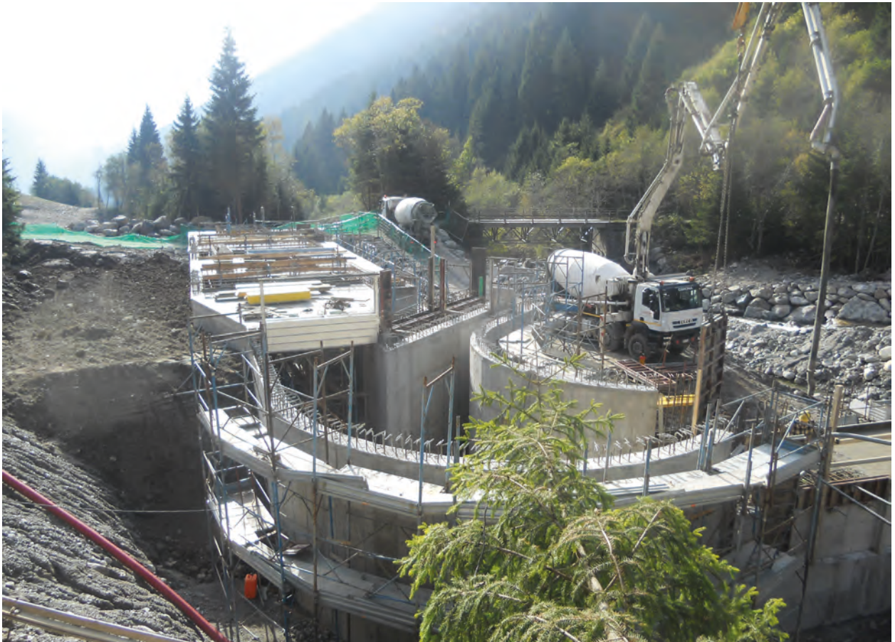
Presa Spinelle- getti di chiusura e completamento canali
