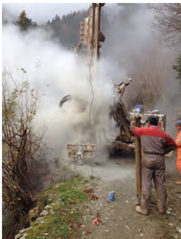
Lavori di consolidamento sul 1° tornante della Strada di Restena
