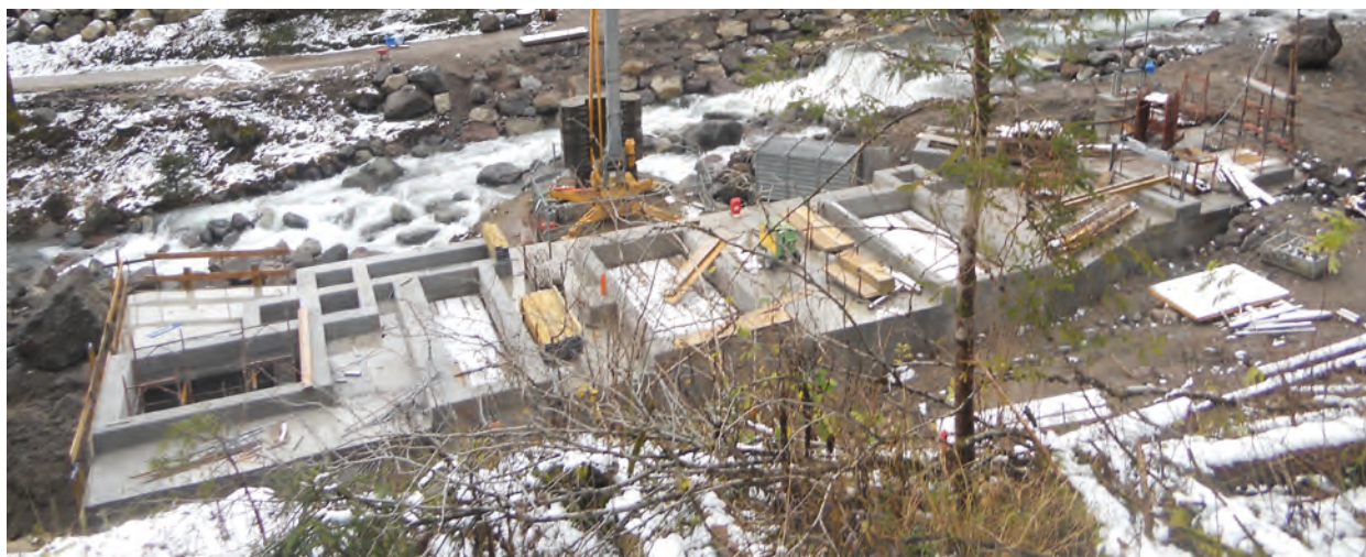
Presa Calamento - completamento del solaio e ripristino argini
