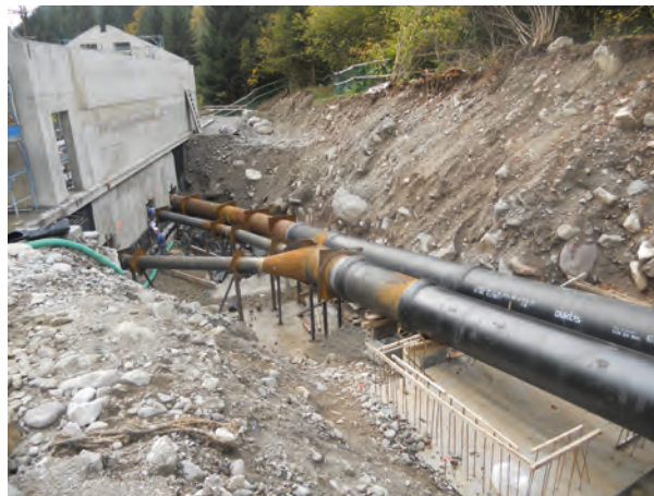
Zona Centrale - posa in opera pezzi speciali di raccordo tra edificio e condotte di adduzione
