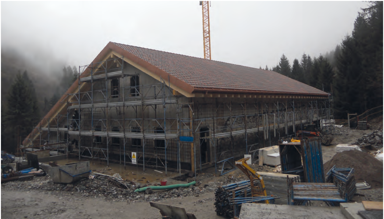
Zona Centrale - copertura dell'edificio e inizio rivestimento in pietra
