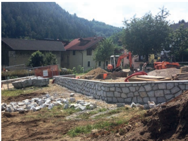
Parcheggio in costruzione località Parise
