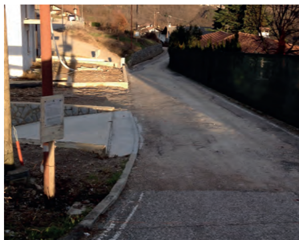
Lavori in località Ziropa
