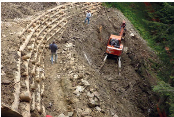
Messa in sicurezza "Dissesto Frattoni Cere"
