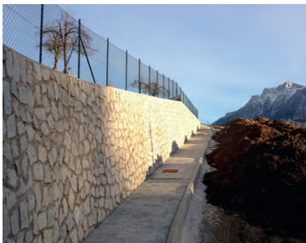
Lavori in via Borgo
