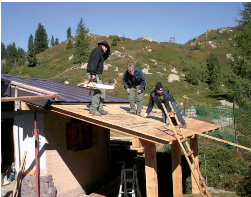
Lavori alla baita dei fanti
