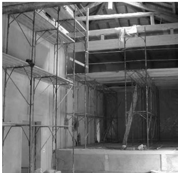
Lavori in corso al teatro Don Bosco
