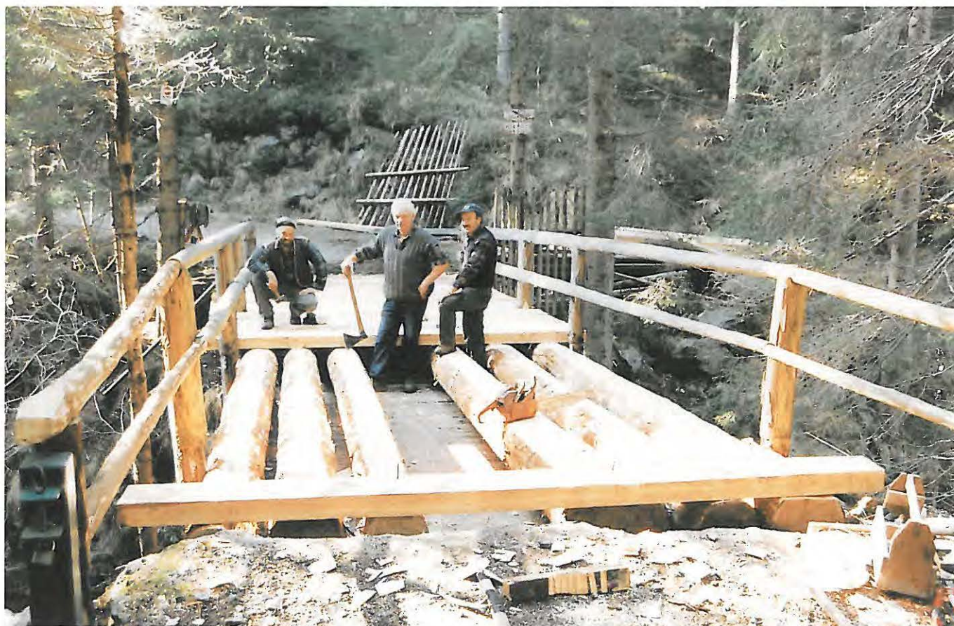
Risanamento ponte "Valtrigona" - Enrico Fedele, Paolo Pecoraro (Saltèro), Carlo Dalsasso.
