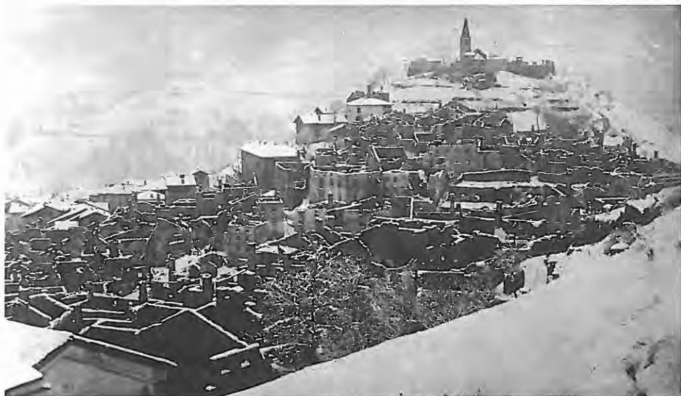
Inverno 1916-1917. Castel Tesino, ridotto ad un cumulo di macerie carbonizzate, con la sola eccezione del quartiere di Terrasanta.
