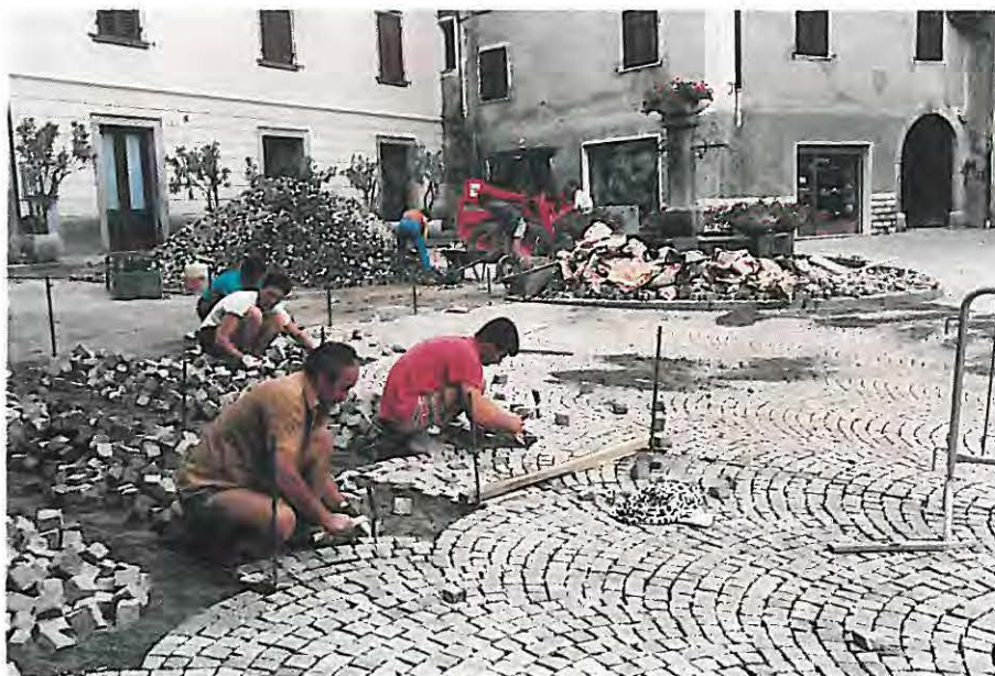
Ripavimentazione strade del paese: posa cubetti di porfido in Piazza Vecchia.
