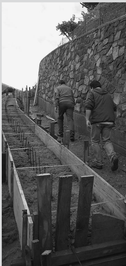
Sentiero delle Scalette. In senso orario: le fondazioni del muro a valle; particolare della muratura nel tratto a valle; il ripristino delle terreno della pista di accesso.
