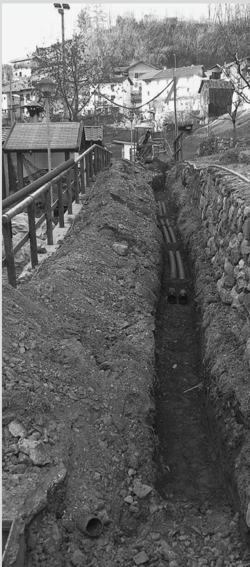
Dall'alto a sinistra, in senso orario: i lavori per la realizzazione della nuova struttura al parco urbano; particolare della nuova staccionata per l'accesso al cimitero; la posa dei cavidotti per l'alimentazione elettrica.
