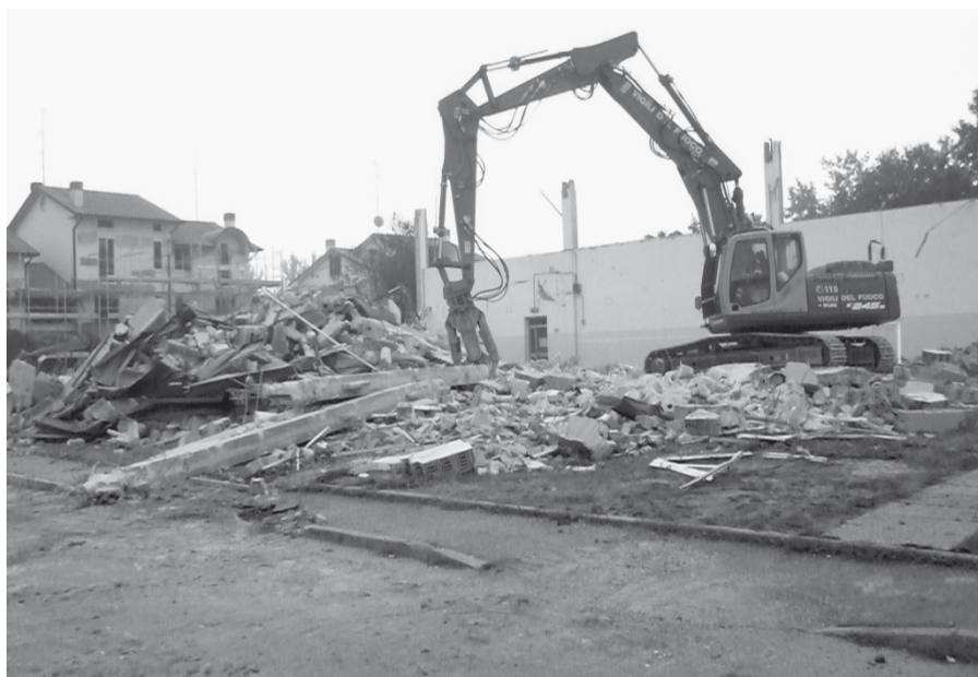
La demolizione della palestra lesionata dal terremoto.
