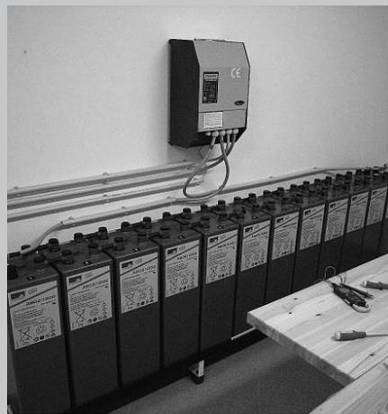
*Il pacco batterie a gel e l'inverter installati in loc. Primalunetta.*
