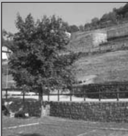
Parco urbano: il muro di sostegno della stradina
