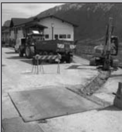
Prolungamento acquedotto in via Strigno - Sala polifunzionale
