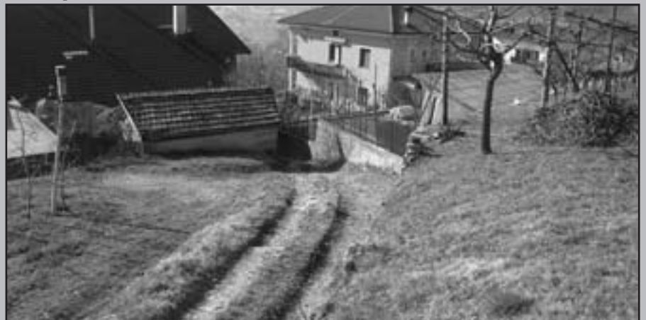
La strada in località Pagheti prima dell'intervento
