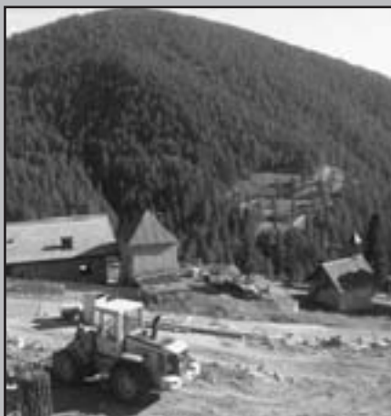
Località Primalunetta: la colonia durante i lavori
