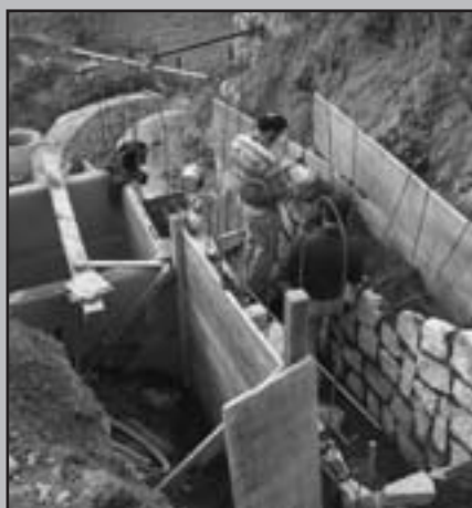
Fognatura intercomunale: tratto in canale in via Carzano con particolare cambio di quota per la dissipazione della velocità dell'acqua
