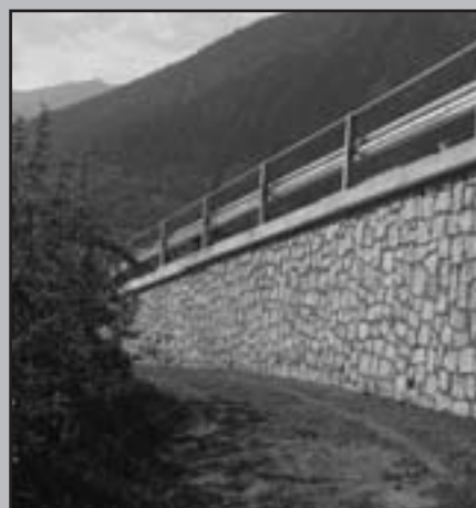
Particolare del muro di sostegno
