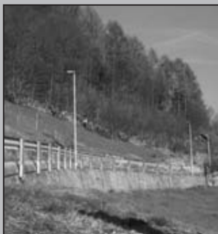
Nuovi pali dell'illuminazione pubblica sulla strada "dele Tonelete"
