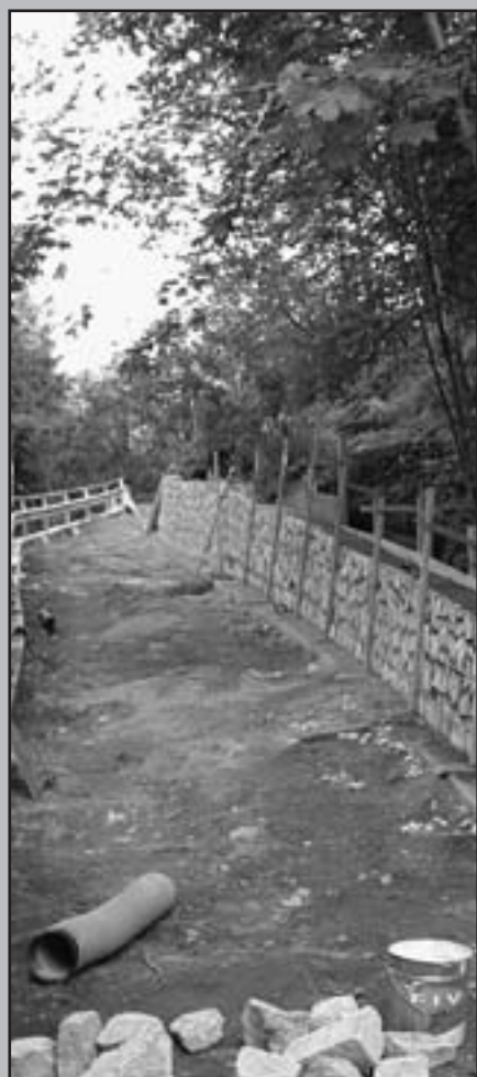
Strada Coste Erte: ricostruzione del muro a monte
