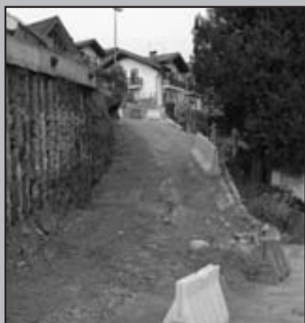
Via Strigno: allargamento bretellina di congiunzione con la provinciale
