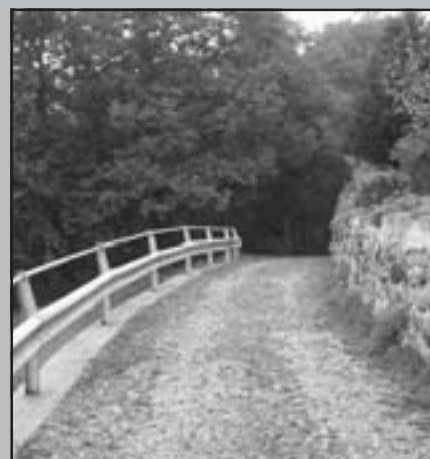
Tratto finale della strada "dele Valpromere" al termine dei lavori
