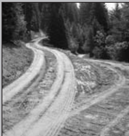
Località Primalunetta: il nuovo imbocco della strada
