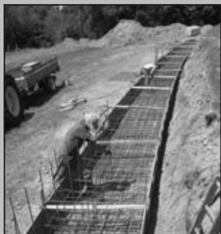
Armatura fondazioni muro sull'ultimo tratto della strada "dele Valpromere"
