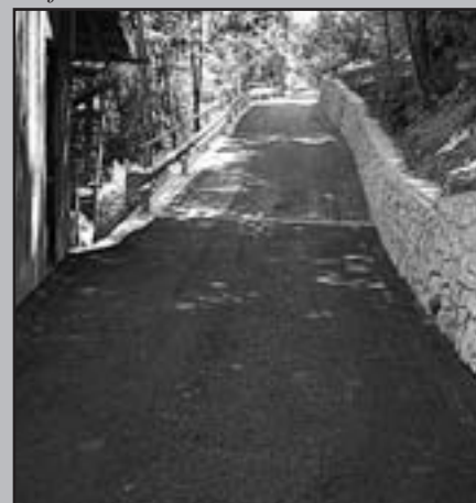
Strada Coste Erte: al termine dei lavori
