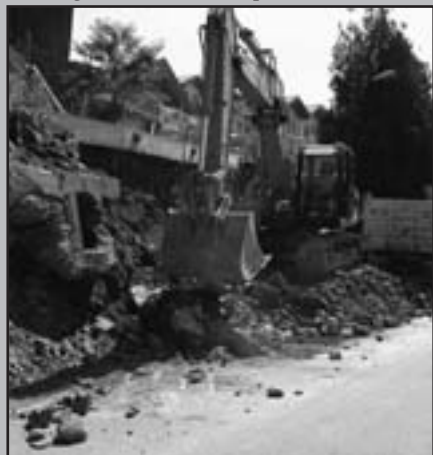
Via Strigno: sbancamento per realizzare un tratto di marciapiede sulla SP 42
