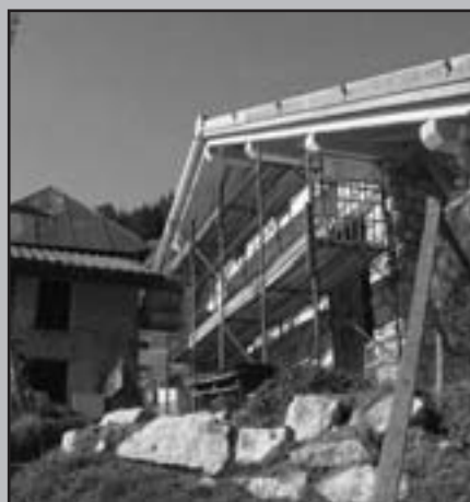
Località Primalunetta: la colonia durante i lavori
