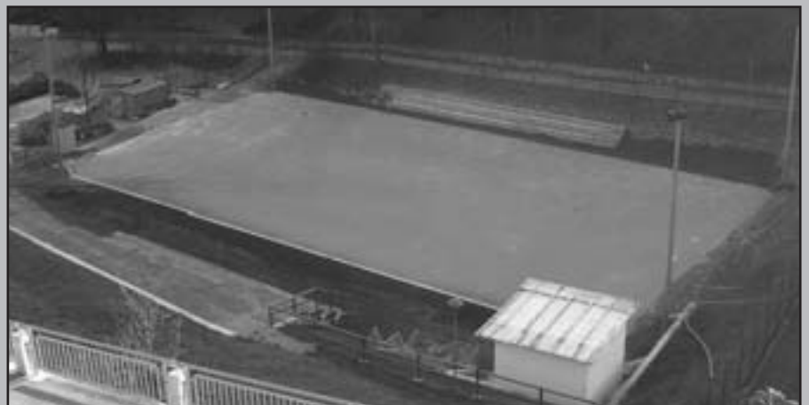
Parco urbano: preparazione piani del campo da calcetto in sintetico
