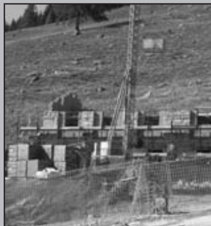
Località Primalunetta: il dormitorio durante i lavori, lato sud e ovest
