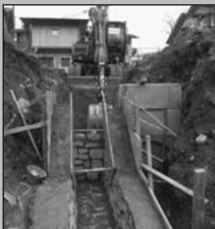
Fognatura intercomunale: tratto in canale in via Carzano con particolare cambio di quota per la dissipazione della velocità dell'acqua
