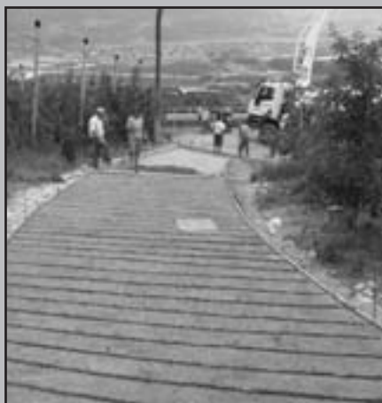
Pavimentazione in calcestruzzo dei tratti caratterizzati da pendenza elevata della strada dei Pagheti
