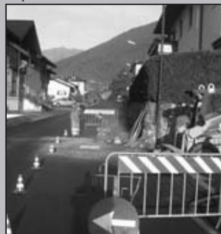
Via Strigno: messa in quota dei chiusini
