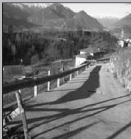
Guard rail sull'ultimo tratto della strada "dele Tonelete"
