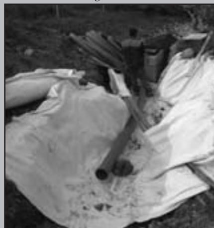
Posa del tubo di raccolta delle acque bianche e ripristino drenaggi
