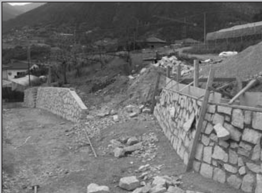
Ricostruzione del muro a monte strada dei Pagheti e ripristino accesso ai fondi
