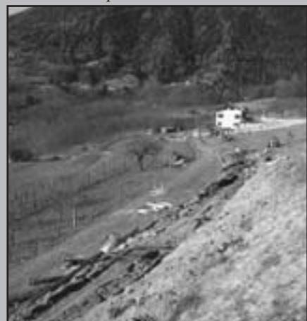
Fognatura intercomunale: località Campilonghi
