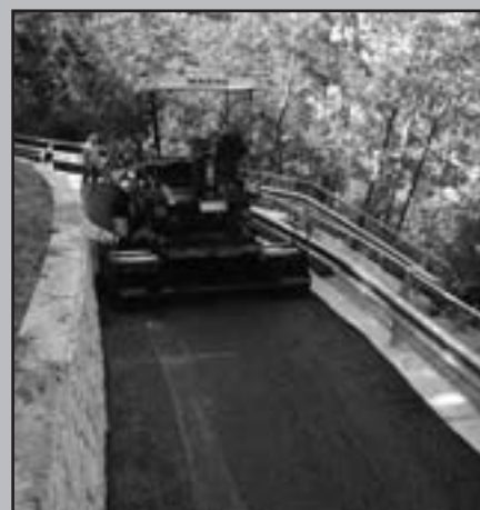
Strada Coste Erte: l'asfaltatura
