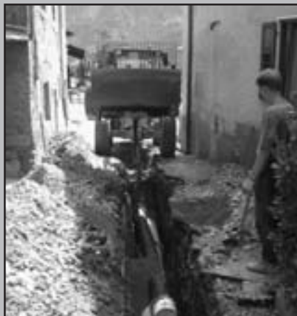
Fognatura intercomunale: posa tubatura in località Torgheli
