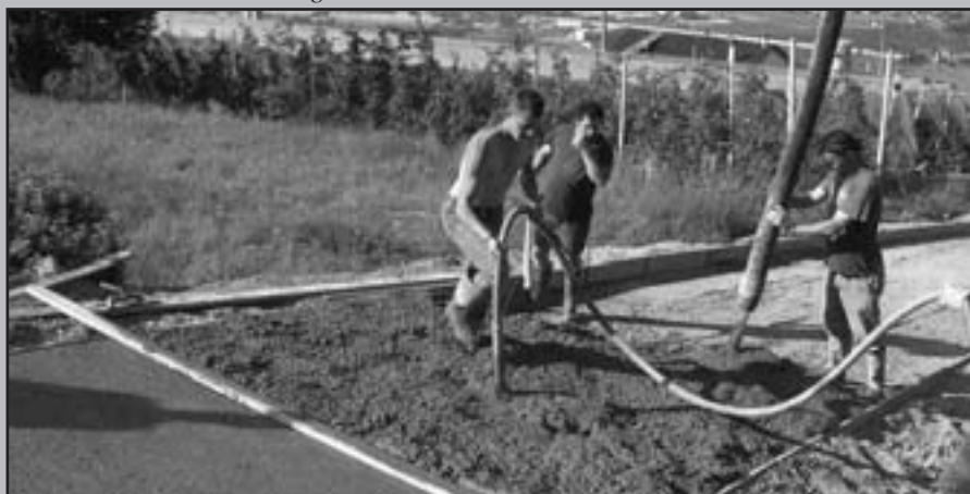
Pavimentazione in calcestruzzo dei tratti caratterizzati da pendenza elevata della strada dei Pagheti
