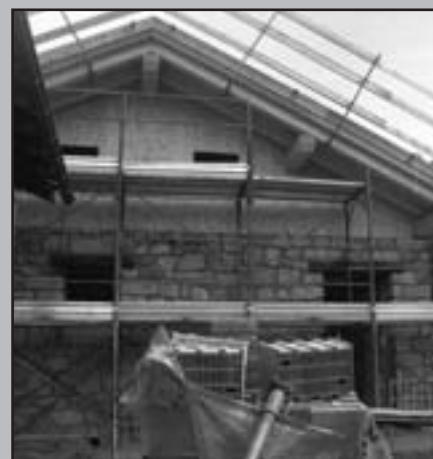
Località Primalunetta: la colonia durante i lavori
