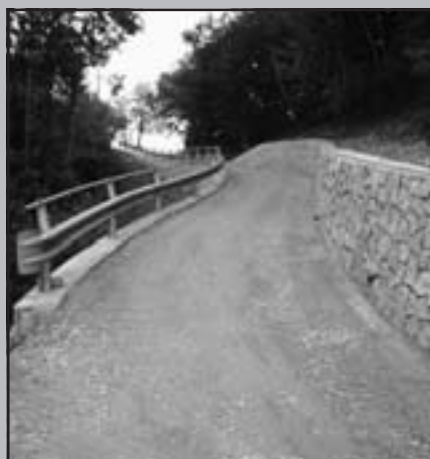
Strada Coste Erte: prima dell'asfaltatura
