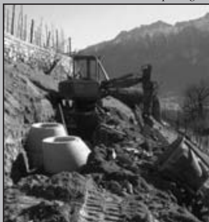
Fognatura intercomunale: posa delle tubature in località Campilonghi
