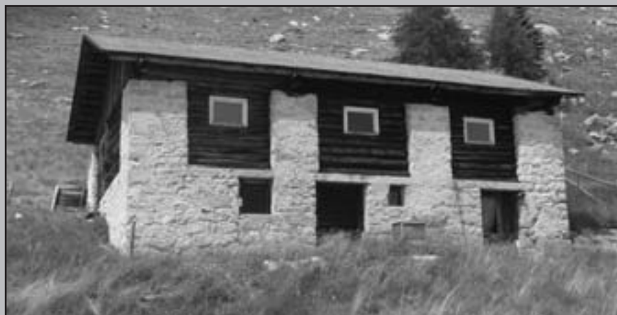
Località Primalunetta: il dormitorio prima dell'intervento
