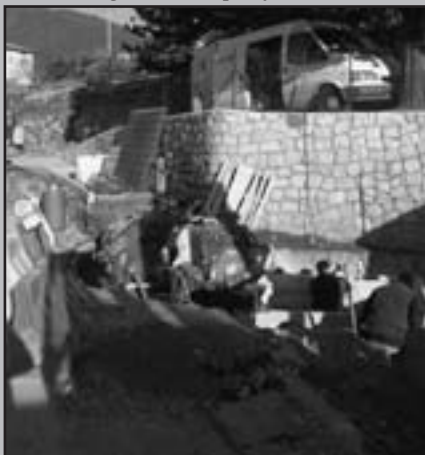
Posa nuova cameretta di ispezione su ramale acquedotto in via Strigno
