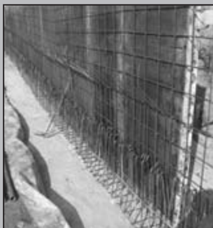
Particolare dell'armatura della schiena del muro
