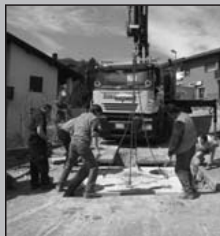
Prolungamento acquedotto in via Strigno: pozzetto sala polifunzionale
