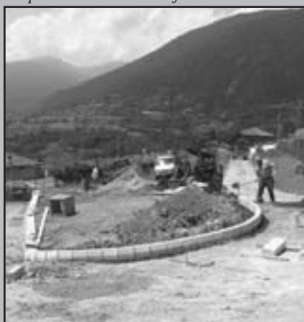
Posa delle cordionate sul tornante
