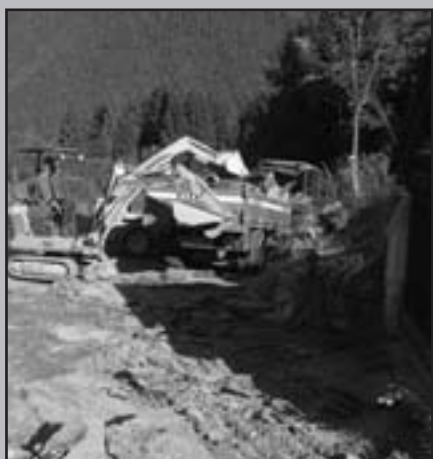
Sistemazione e formazione piani della strada in località Batistoti
