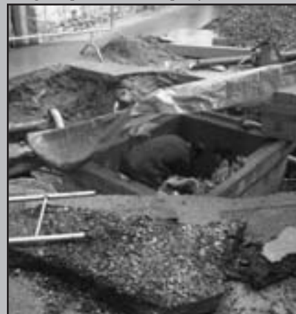
Acquedotto in via Canonica: posa della cameretta di ispezione
