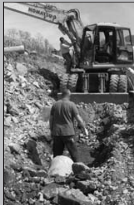
Posa della tubatura per la raccolta delle acque bianche
