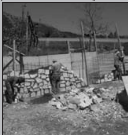
Ricostruzione del muro a monte su strada dei Pagheti
