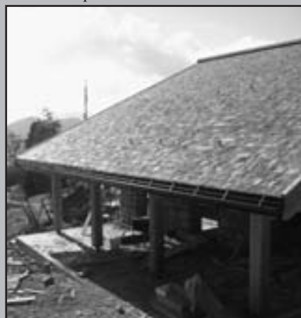
Località Primalunetta: particolare della copertura in scandole
