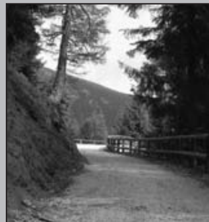
Località Primalunetta: sistemazione e allargamento della strada
