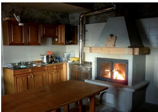
molito il focolare centrale, tolta una delle due scale che portavano al sottotetto, posato il pavimento, isolato e piastrellato il muro verso monte, allestito un nuovo angolo cucina e montato il caminetto. La nuova disposizione ha permesso di ampliare lo spazio a disposizione dei frequentatori.
