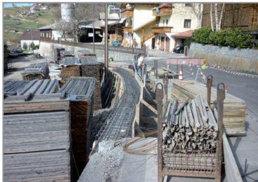
Sono proseguiti anche nel 2012 gli interventi di messa in sicurezza della viabilità comunale. I lavori sulla strada delle Zunaghe hanno consentito di migliorare la sicurezza in Via Nuova superiore e Via Lunazza, dove su nuovo cordolo in calcestruzzo è stato posato il guardrail ai lati del ponte sul Rio Cinaga e a protezione del lato a valle della strada.
