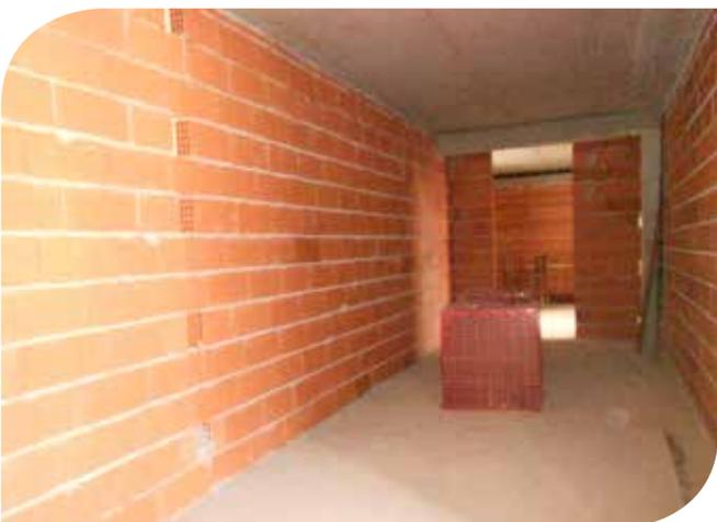
Al piano terra si stanno posando le pareti perimetrali. È iniziata la realizzazione dell'impianto idro-sanitario con il montaggio delle staffe e dei relativi tubi a soffitto al piano terra e primo.
