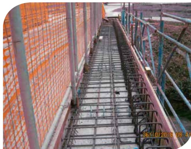
Contestualmente sono state pertanto rimosse tutte le parti friabili, ricoperti i ferri in vista con una resina passivante che interrompa la corrosione e ripristinato il copriferro con delle malte ad alta resistenza.
