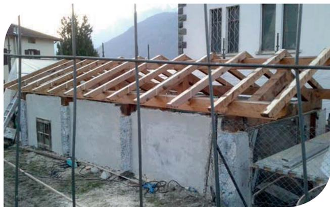
In particolare è stata sostituita la travatura della copertura ed il relativo manto in tegole di cemento, sono stati sostituiti i canali di gronda e le lattonerie e si è provveduto a rimuovere e rifare l'intonaco esterno laddove lo stesso si presentava ormai privo di consistenza e deteriorato.
