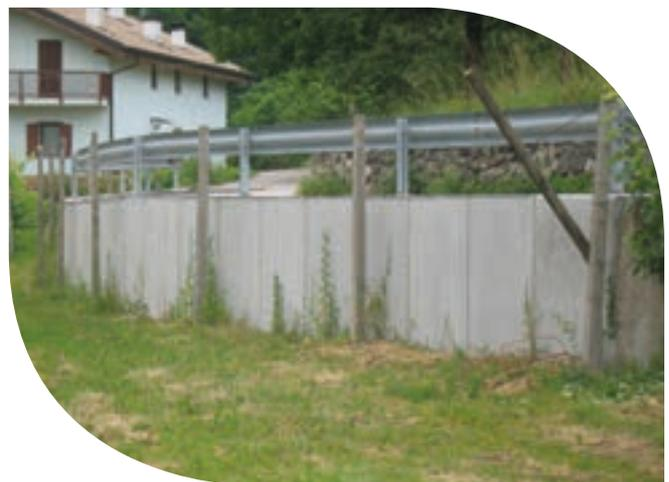
Simile intervento è stato eseguito in Via Bolleri, dove anche qui si è provveduto a rifare 40 m circa di muro a sostegno della sede stradale. In questo caso, sulla sommità dello stesso è stata installata una barriera di protezione a doppia onda in acciaio.
