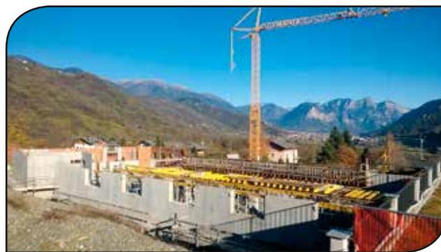
to delle fondazioni, la realizzazione dei primi muri perimetrali e i pilastri e la realizzazione dei solai. Presumibilmente entro l'inverno, tempo permettendo, sarà realizzata anche la copertura.
