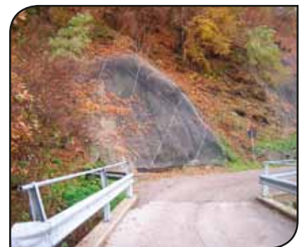
Messa in sicurezza versante Montibelleri
