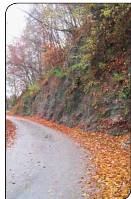
Messa in sicurezza versante Tinotto
