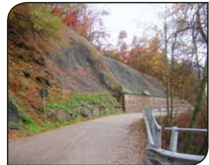
Messa in sicurezza versante Montibelleri
