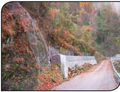
Messa in sicurezza versante Loc. Rozza
