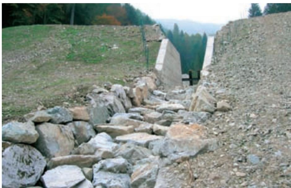
con il profilo del terreno è assicurato da una rampa in massi cementati.
