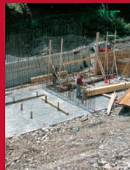
Una fase dei lavori nel maggio 2006: La fondazione in cls dell'opera e la costruzione di uno dei due muri di sponda del canale che attraverserà il tomo
