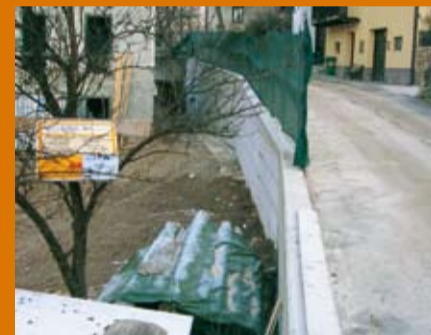
Costruzione di un nuovo muro in località Zaccon
