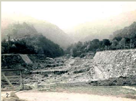
2 - Come si presentava nel 1925 il tratto di torrente Larganza. La diffusa presenza di sorgenti di sedimento nella parte alta del bacino orientò i sistematori dell'epoca a dimensionare una sezione estremamente cautelativa e capace di "funzionare" anche come zona per la sedimentazione del materiale grossolano prima del tratto pianeggiante.
