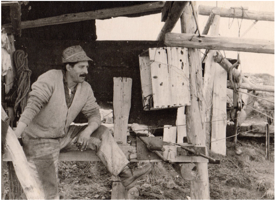
Cava di monte Cima, 1960/1964, Erminio Raffi davanti al banco dei freni della teleferica. A destra in basso si notano le due manovelle usate per bloccare la teleferica quando non era in uso, mettendo in sicurezza l'impianto.
