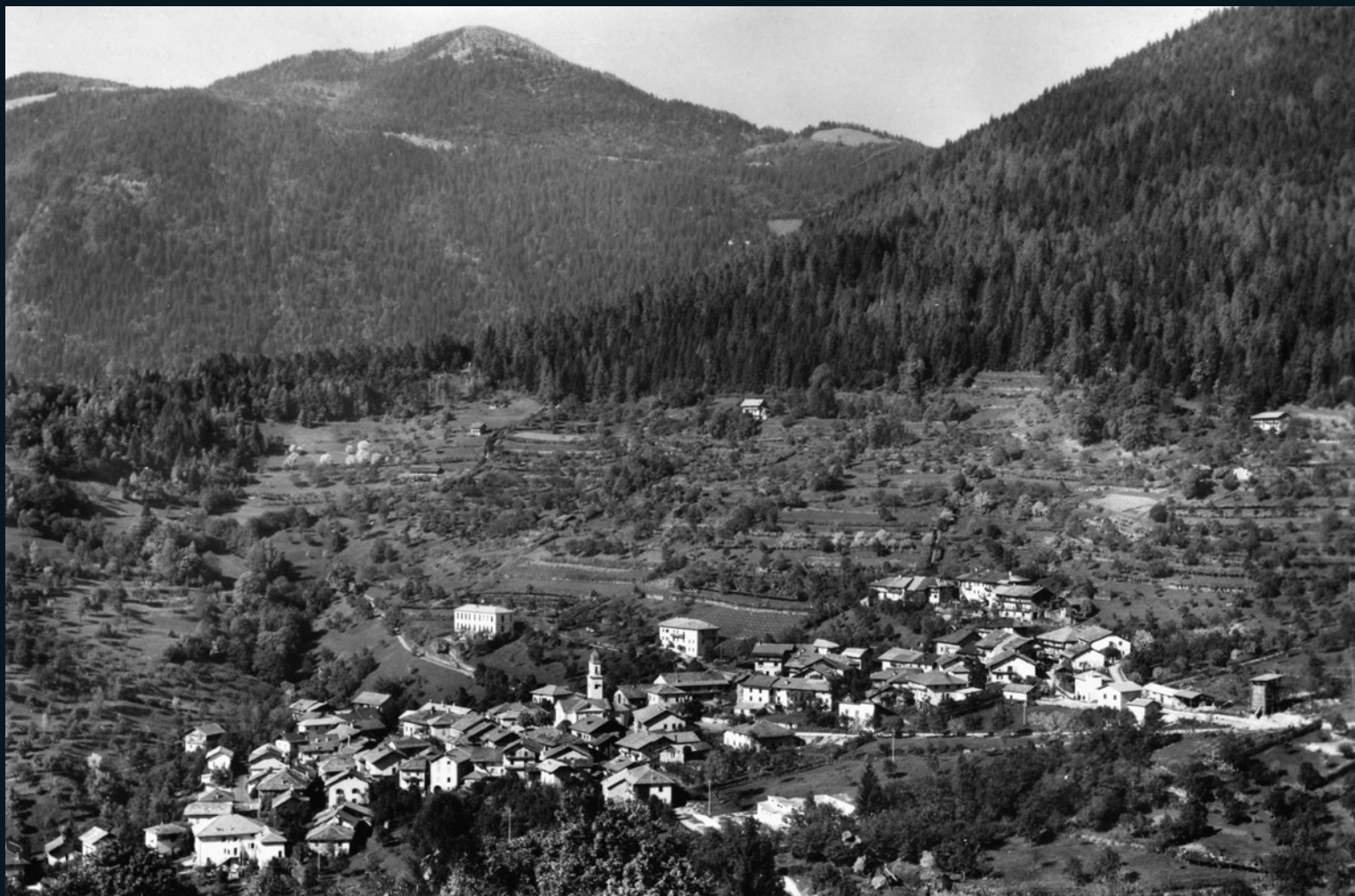
Samone negli anni Sessanta. In basso a destra la stazione di arrivo della teleferica con la tramoggia a valle.
