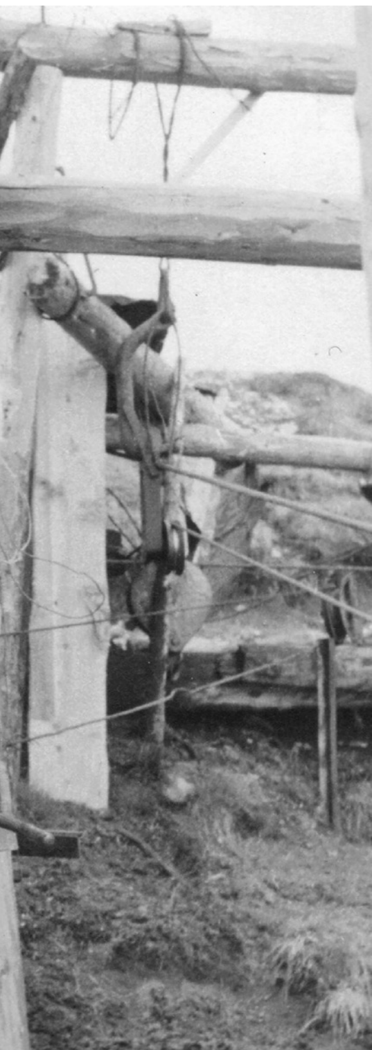
Cava di monte Cima, 1960/1964, Erminio Raffi davanti al banco dei freni della teleferica. A destra in basso si notano le due manovelle usate per bloccare la teleferica quando non era in uso, mettendo in sicurezza l'impianto.
