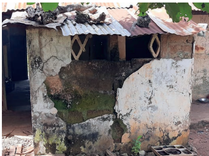
Uno dei bagni da ristrutturare
