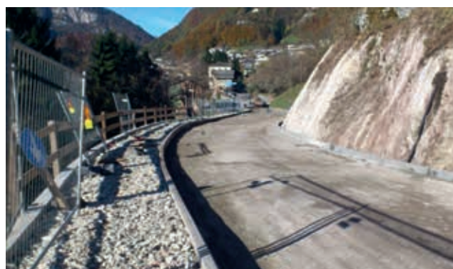
Vista della nuova carreggiata con marciapiede
