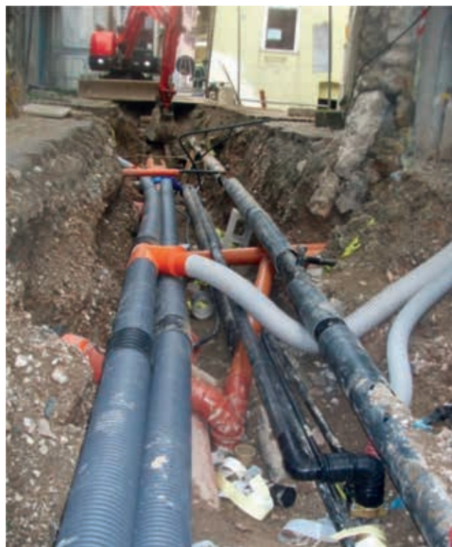
La complessità dei lavori di posa in opera delle diverse tubazioni in Via Degasperi
