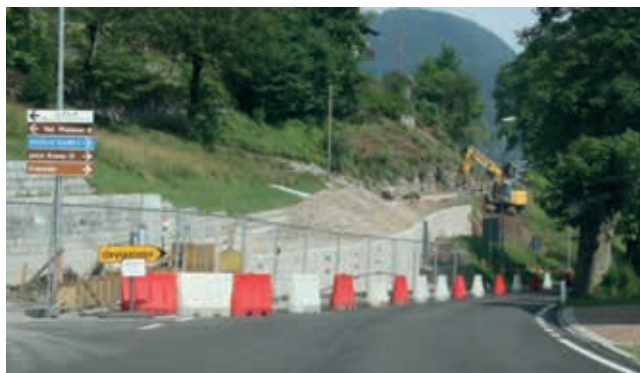
Vista del cantiere dall'incrocio con la S.P. del Tesino
