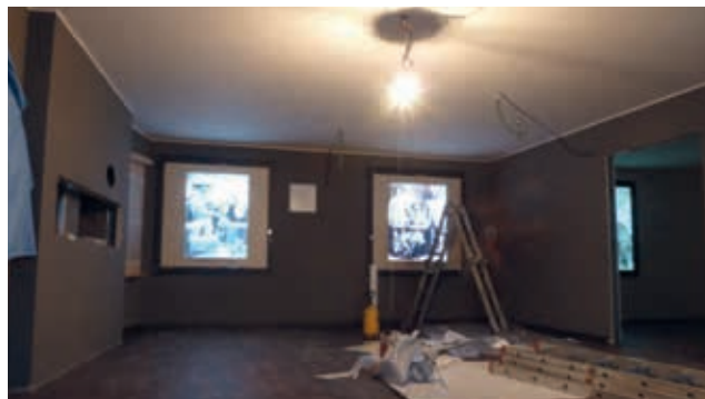
Si stanno approntando gli allestimenti interni
