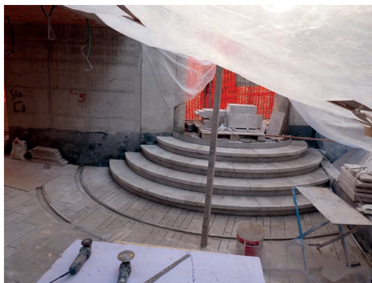
Realizzazione scala entrata principale
