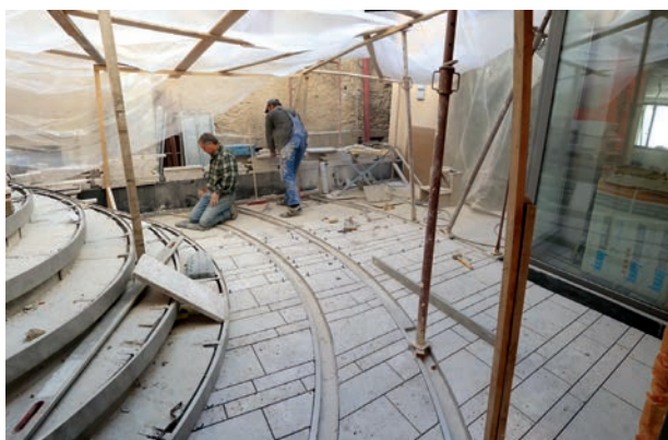
Posa in opera pavimento entrata principale
