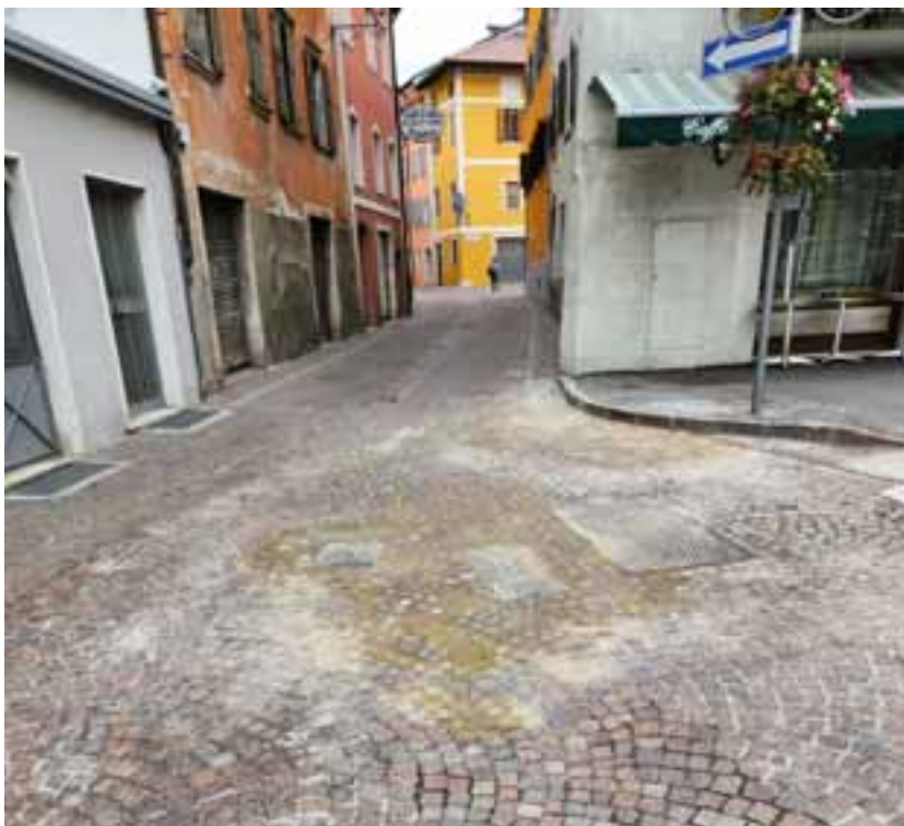
L'accesso di via XXIV maggio da piazza Martiri della Resistenza, in centro: ora la pavimentazione a cubetti di porfido è stata sistemata
