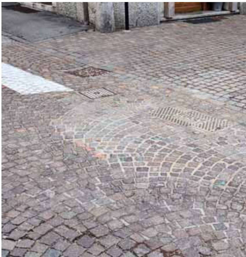
Un dettaglio dei lavori di sistemazione del fondo stradale successivo agli interventi di interrimento delle condotte per il passaggio della fibra ottica in paese
