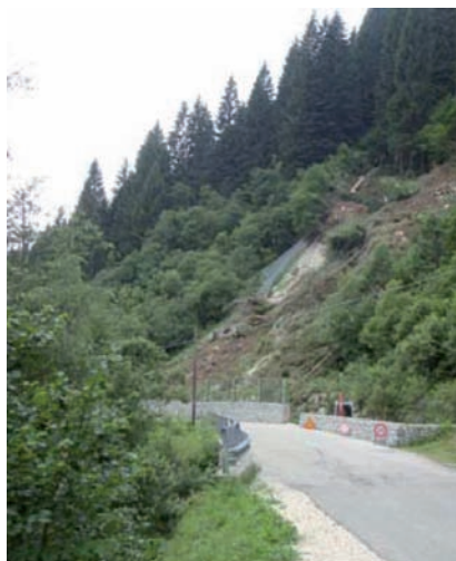
Prima dei lavori
