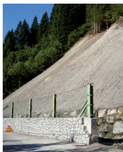
Dopo i lavori
