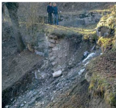
DOCUMENTAZIONE FOTOGRAFICA PRIMA DEI LAVORI
