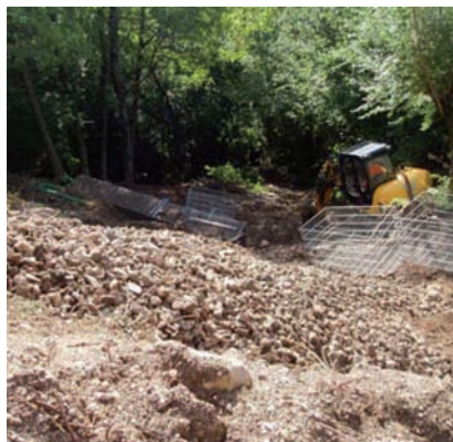
DURANTE I LAVORI E A LAVORI ULTIMATI
