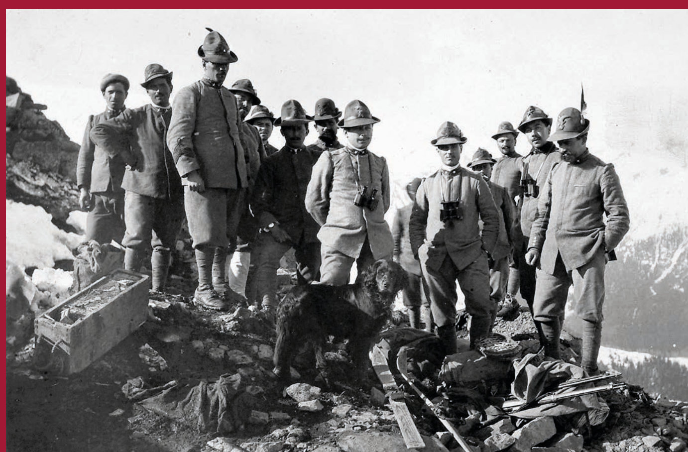
Recupero di materiali travolti da valanga a monte setole. Primavera 1916 | Foto: Biblioteca Baldini - Roma, Fondo Monelli
