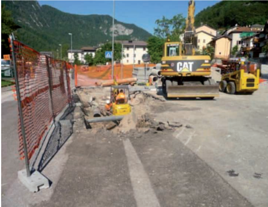
Si scava lungo la Circonvallazione
