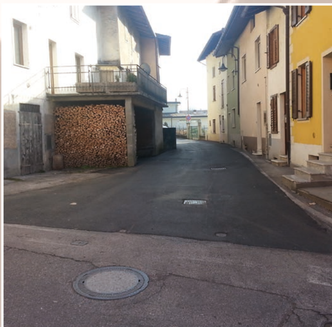
Bitumatura strade interne al centro abitato
