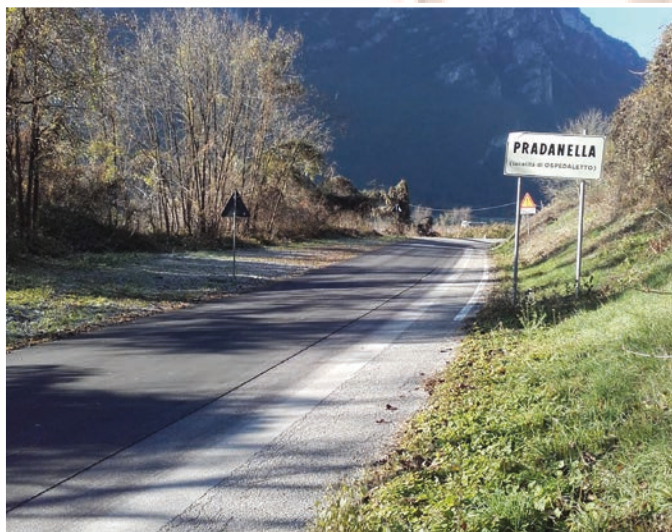
Sistemazione ex SS 47 con l'esecuzione di manto bituminoso
