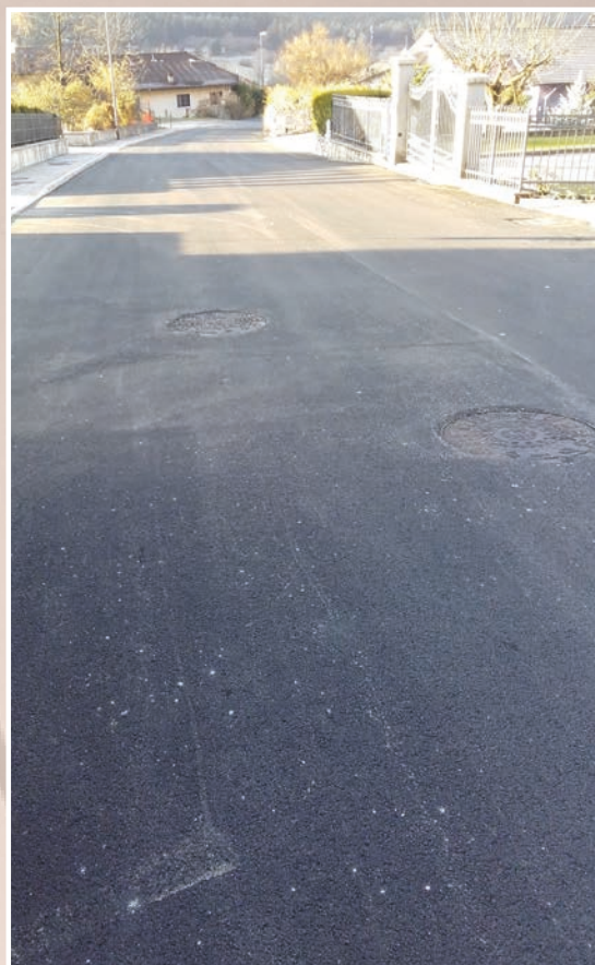
Bitumatura strade interne al centro abitato
