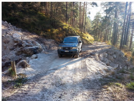
Completati i lavori di sistemazione della strada forestale in Val Bronzale.
