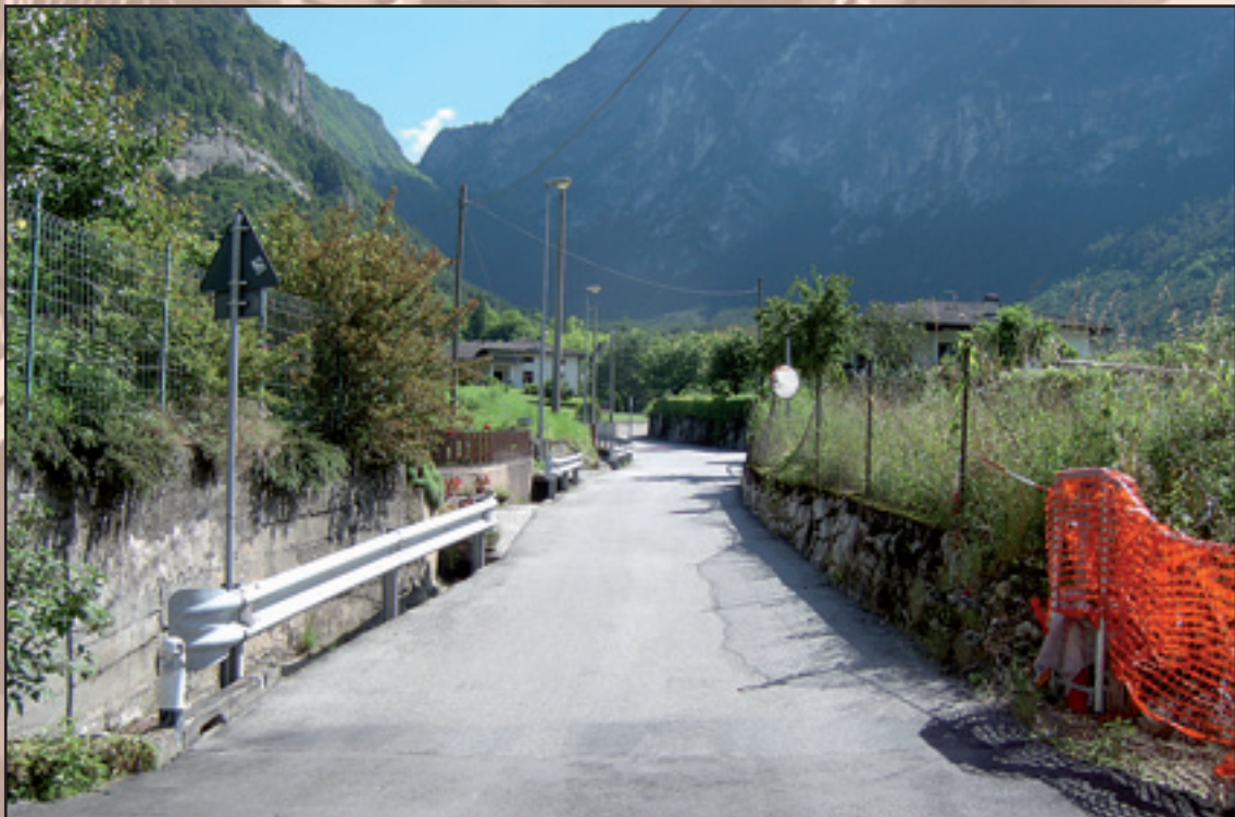
Sono in corso, a cura della ditta Nicoletti Gino Scavi di Ospedaletto, i lavori per la realizzazione del nuovo marciapiede con interrimento della roggia, delle reti tecnologiche ed edificazione di nuovi muri in via Bronzale.
