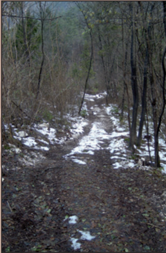
il Cantiere comunale ha eseguito le opere di sistemazione della viabilità forestale in Val Bronzale e in località Col dei Pini.
