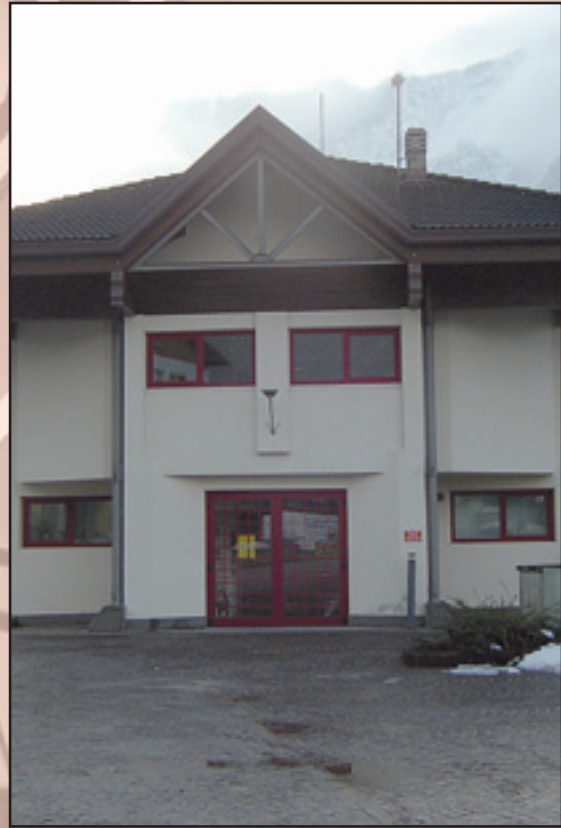
La tinteggiatura dell'edificio polifunzionale e magazzino Vigili del Fuoco è stata eseguita dalla World Color Snc di Telve.
