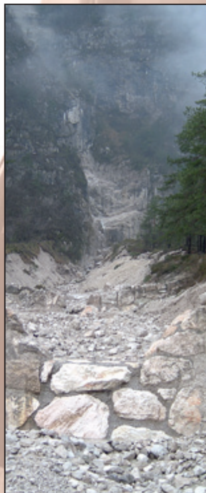
La Nicoletti Gino Scavi di Ospedaletto ha completato i lavori di sistemazione idraulica dell'alveo del Rio Val del Lever.
