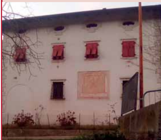
Palazzo Pontara visto da Via Principale
