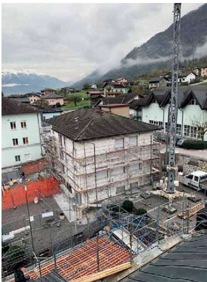
La ristrutturazione del Municipio
