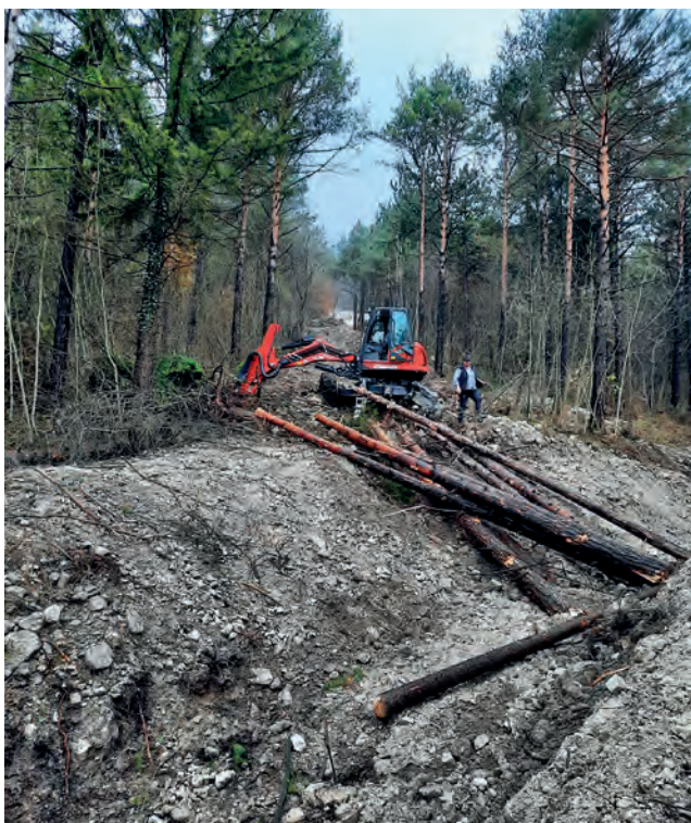
Sopra e nella foto a fianco i lavori per il ripristino della frana in località Monegarie
