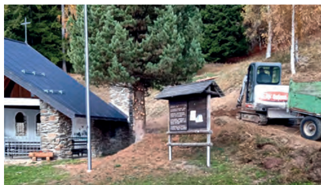
I lavori di restauro alla Chiesetta degli Alpini
