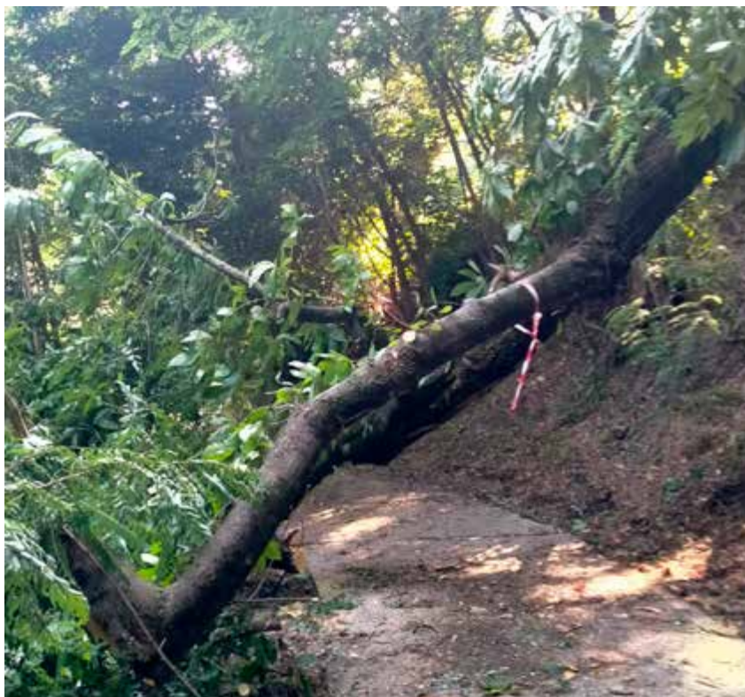
Intervento rimozione piante da sede stradale
