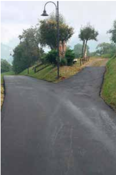
I lavori di asfaltatura
