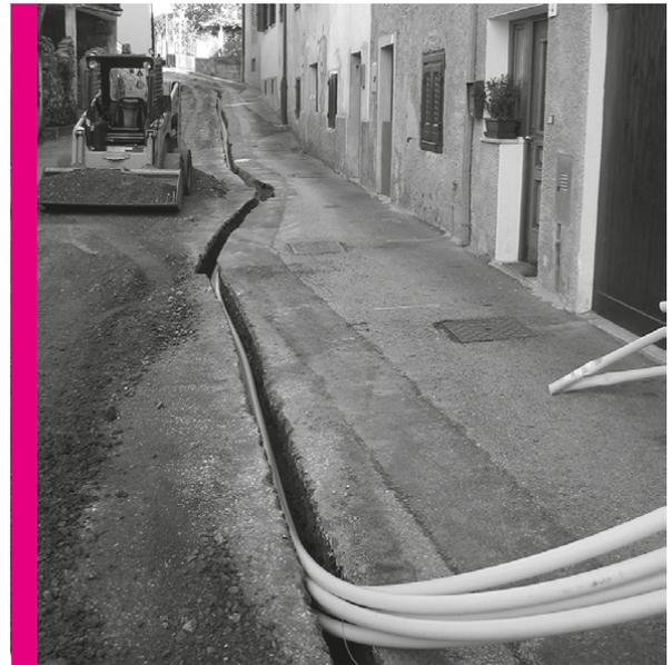
ministrazione comunale per ogni singolo immobile da collegare alla rete. Le opere a carico del Comune hanno riguardato in estrema sintesi, la formazione di scavi, posa di tubazioni e pozzetti, ripristini della sede stradale.
