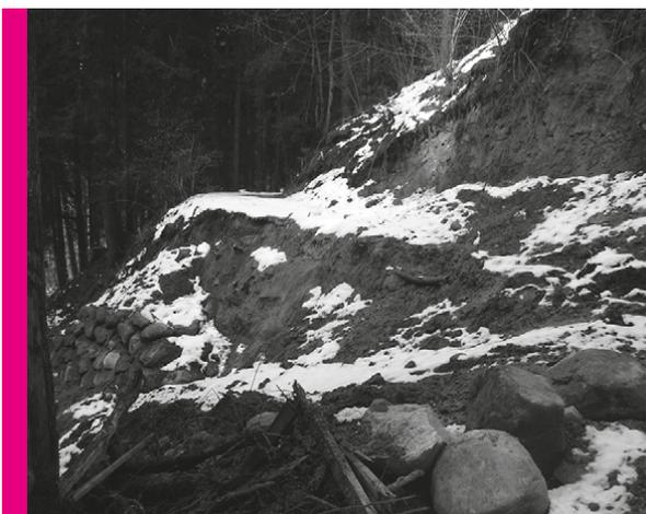
complessivo di 460 metri ed è interamente di proprietà del Comune di Bieno. I lavori di manutenzione straordinaria interessano una lunghezza di circa 50 metri e riguardano la sistemazione di uno smottamento in prossimità del "Boal Gambarota" a quota mille metri, attraverso la rimozione del materiale presente sulla carreggiata stradale, la riprofilazione della rampa di monte e valle, la finitura del piano viabile con legante stabilizzato e la posa di canalette in larice.
