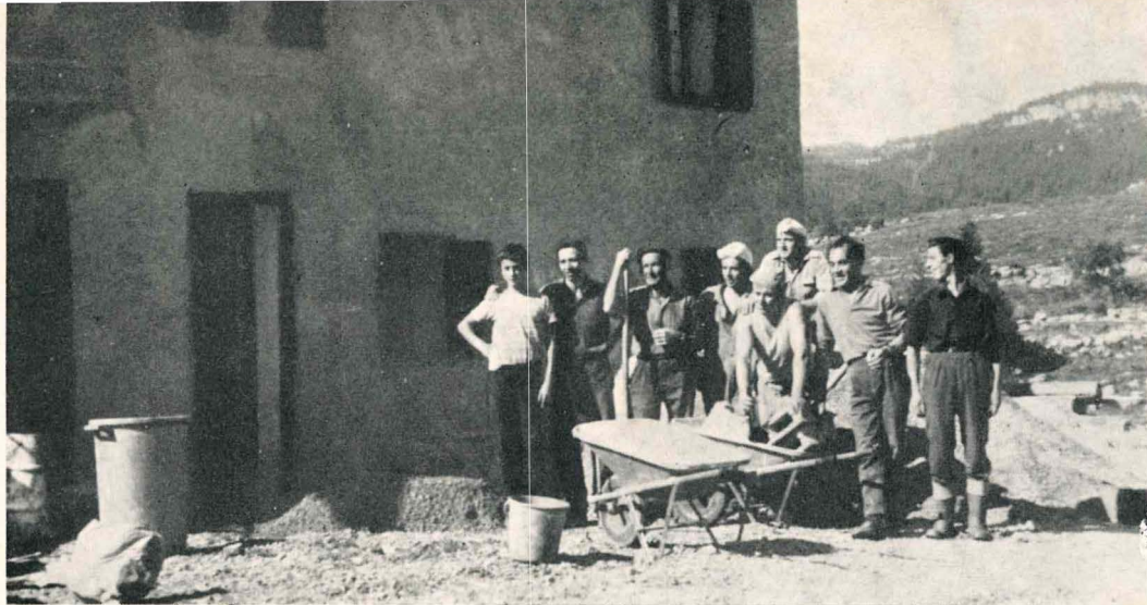
Alla « Barricata » si lavora
