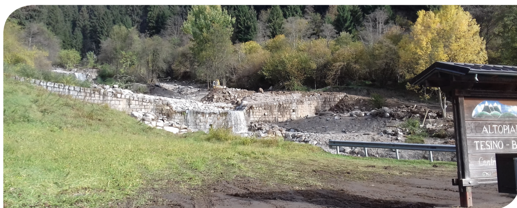
Il torrente Lusumina con parte dei detriti
