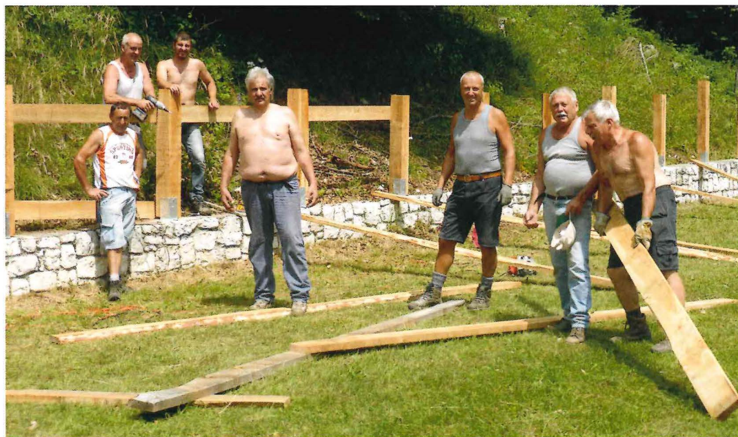
Un momento della realizzazione della recinzione
