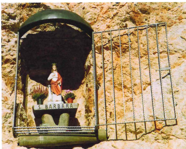
Il capitello di Santa Barbara al termine dei lavori di messa in sicurezza
